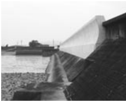
豊川地区堤防
