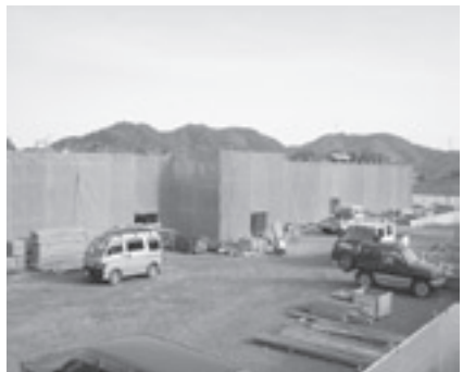
着々と工事が進む市営住宅のキャッスル豊原
