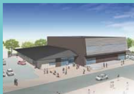
防災拠点センター(小川)
