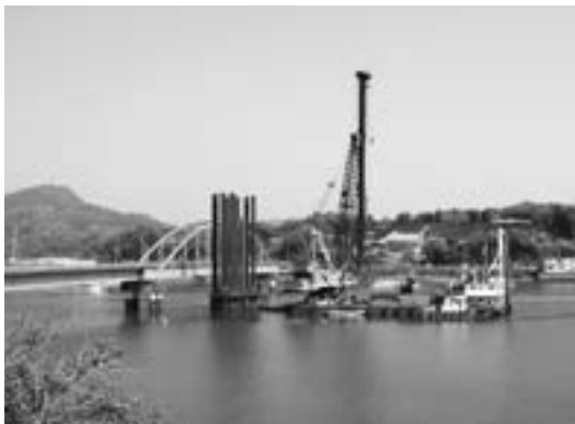
戸馳大橋工事風景
