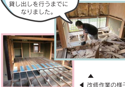
改修作業の様子
