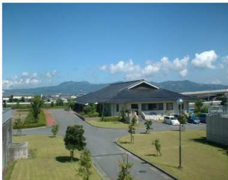
水処理棟より宇土半島を望む。 手前の建物は管理棟です
