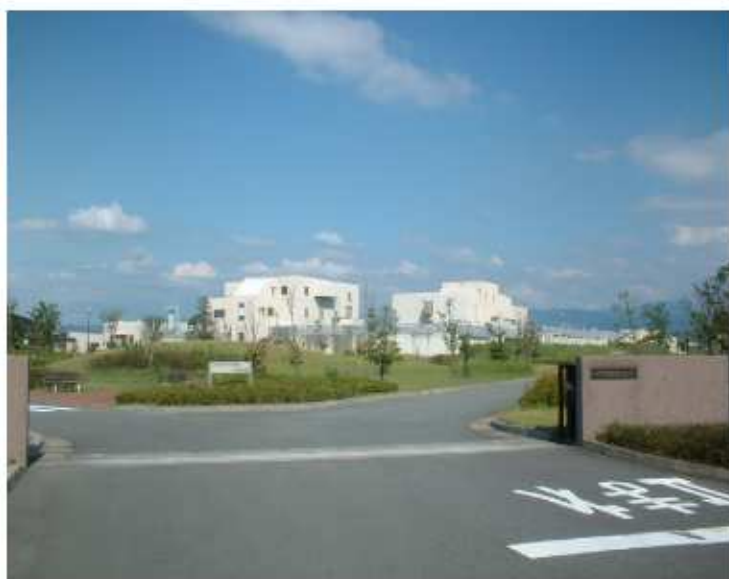
水処理棟全景（入口より） 高い建物の2棟うち、右側は 水処理棟、左側は汚泥処理棟 です。
