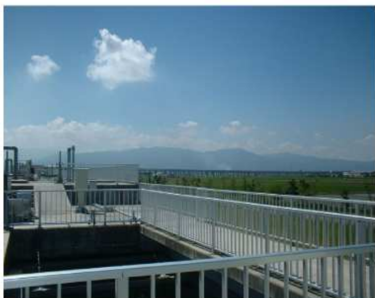
水処理棟より山々を望む。 手前の高架橋は九州新幹線で 現在、工事中です。
