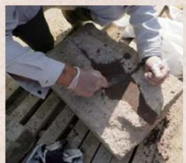
(左)安山岩 (右)馬門石 隙間に石灰を流し込み補修
