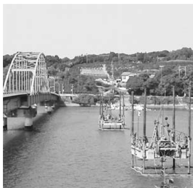
地質調査の様子
