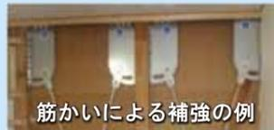
筋かいによる補強の例
