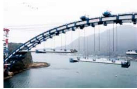
2017 1・2月 橋桁部分を閉じる(補剛桁架設) 写真提供：熊本県
