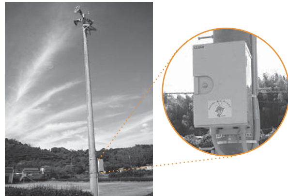
整備されたスピーカーと音声増幅制御盤
