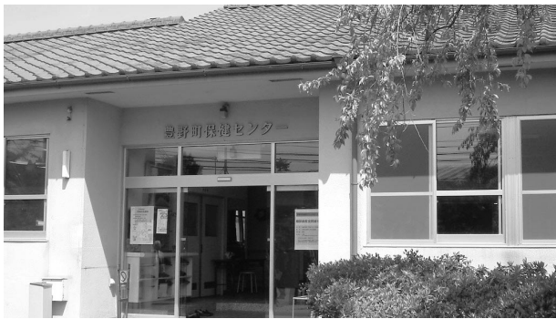
新支所庁舎建設のため解体される豊野保健センター
