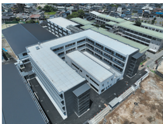
松橋中学校（奥の緑の屋根の部分が解体される建物）
