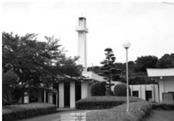
老朽化した火葬場
