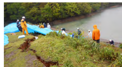
鉦ヶ鼻ため池の堤防に亀裂が入り、応急処置の様子 (H28.4.21 宇城市撮影)
