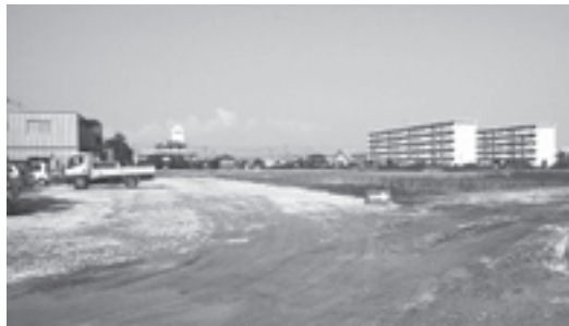
フットボールセンター（仮称）建設に向け整地される益南広場（小川町）
