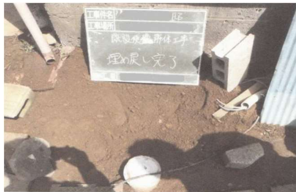
（６）工事完了の写真
