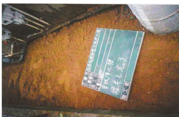
（６）工事完了の写真
