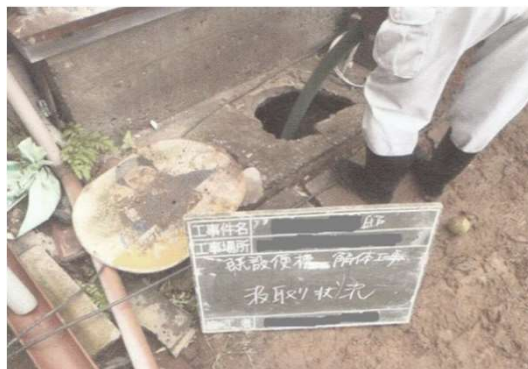
（２）汚泥くみ取作業の写真
