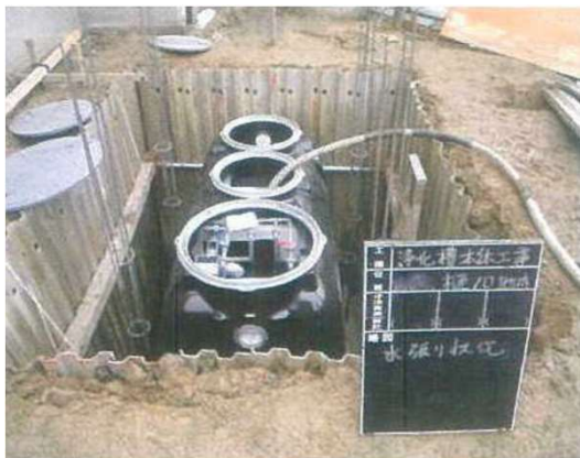
【イラスト4】据付工事の状況を示す写真
