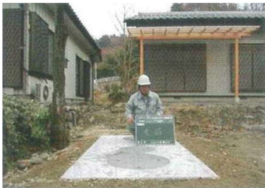
【写真10】 工事完了の写真
