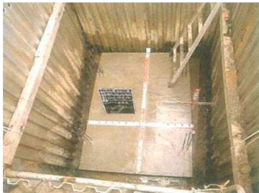
【写真4】 基礎底版コンクリートの状況を示す写真
