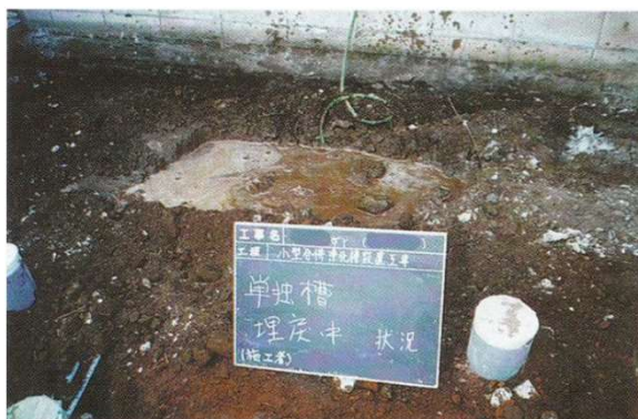
（５）埋め戻し作業の写真
