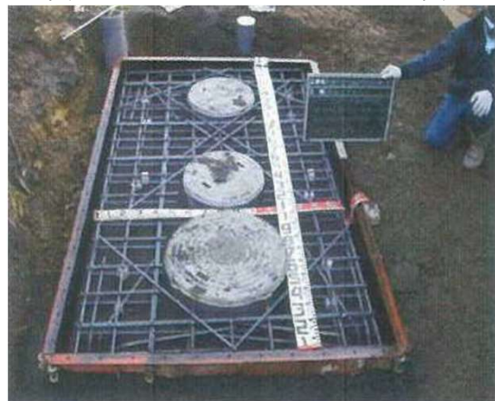
【写真7】上部スラブ工事を示す写真
