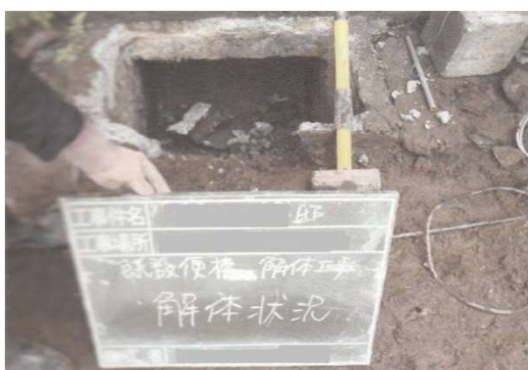
（４）解体又は掘上作業の写真
