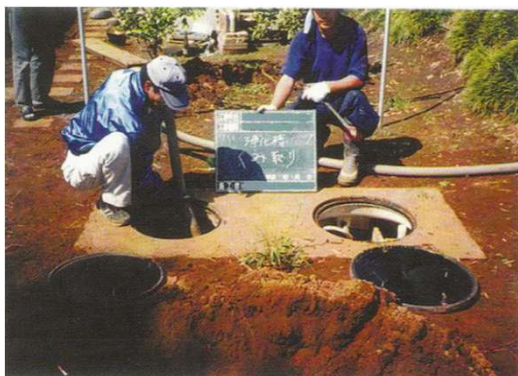
（２）汚泥くみ取作業の写真
