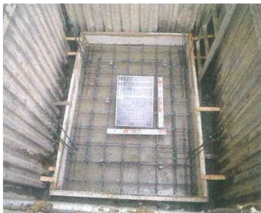
【写真4】 基礎底版コンクリートの状況を示す写真
