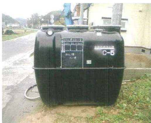
【写真5】 浄化槽本体の写真
