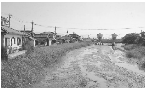
港川防潮水門
