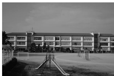
昭和37年に建設され老朽化がすすむ豊野小学校
