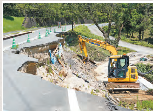
復旧作業が始まった観音山総合運動公園付近(小川町)
