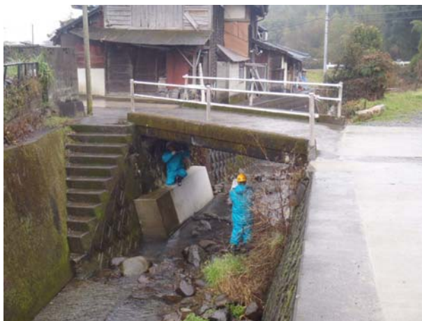
写真-5. 定期点検状況
