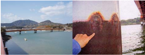
写真-1. モタレノ瀬戸を跨ぐ戸馳大橋 橋長 300.5m 鋼ランガー桁・合成桁橋 昭和 48 年築造 供用年数 41 年
