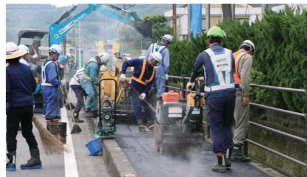
丁寧な作業で真新しい滑らかな歩道に仕上がりました
