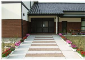
玄関スロープ
