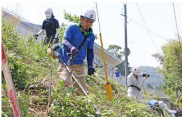
傾斜がきつい斜面での作業
