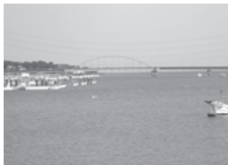
新橋が求められる戸馳大橋
